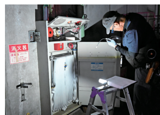
▲消防設備などを点検
