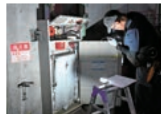
▲消防設備などを点検
