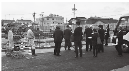
工事中の調整池建設現場
