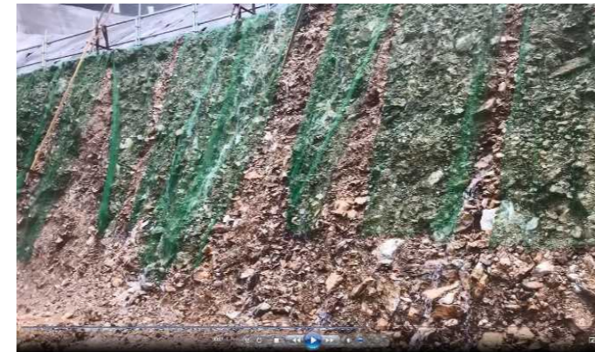
掘削のり面から湧水が流れ出している様子
