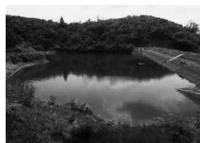
堤体の強度低下が 心配されるため池
