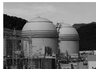
高浜発電所1・2号機
