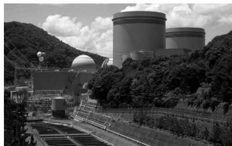
安全対策工事完了
