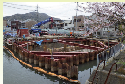
大手ポンプ場の建設現場
