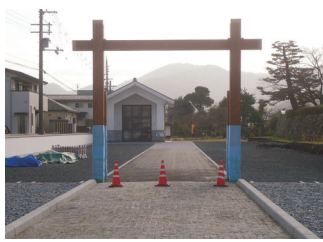
整備中の冠木門
