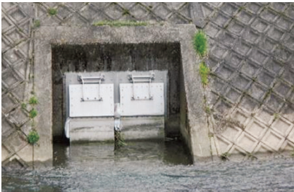
出雲谷橋右岸側の逆流防止施設
