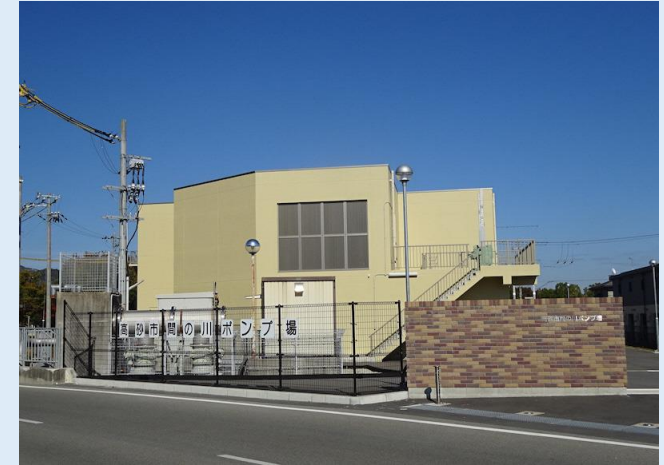
浸水被害防止のためのポンプ場
