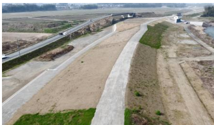
福知山市前田地区 堤防整備の様子
