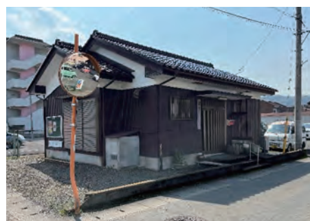
スロープ設置が望まれる地域内集会所
