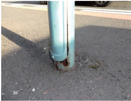
根元が腐食した街路灯
