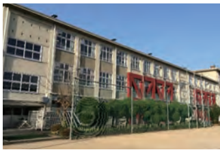
長寿命化工事を検討している倉梯小学校
