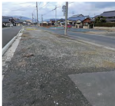
安全対策が問われる市道と和泉通線
