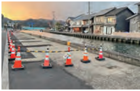
工事準備中の静浜ポンプ場建設現場
