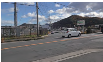
安全対策が必要な松島橋周辺歩道
