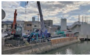
電源建屋工事が進む 大手ポンプ場
