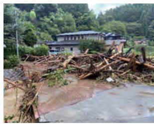
橋に押し寄せた流木
