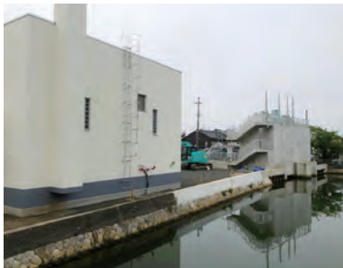
浸水対策に期待される大手ポンプ場
