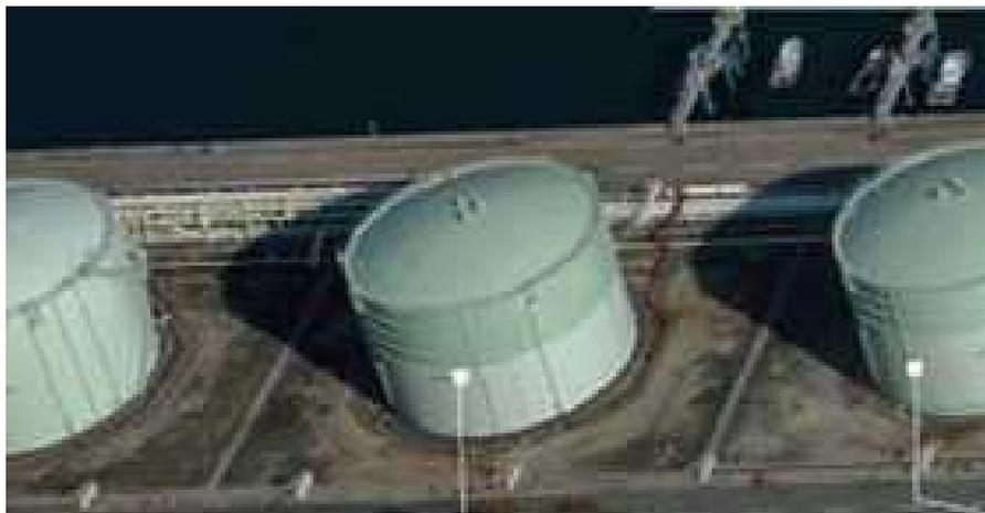
「浮き蓋付屋外タンク」は、インナーフロートタンクとも呼ばれ、固定屋根式タンクの内部に浮き蓋を浮かべる構造となっています。
