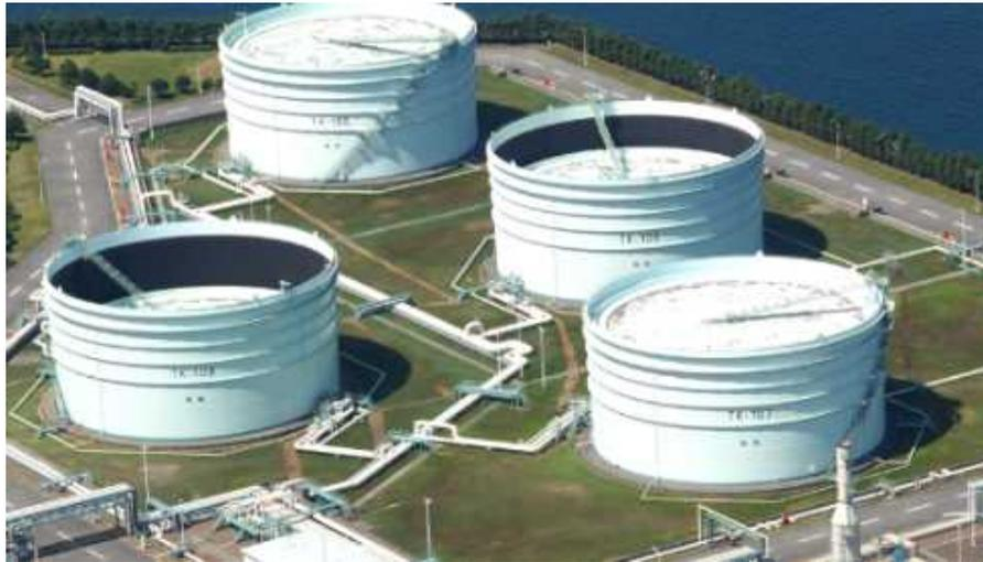
「浮き屋根式屋外タンク」は、比較的大型のタンクに多く見られる屋根形式のタンクで、貯蔵物の液面に鋼製の落とし蓋を浮かべた構造となっています。
