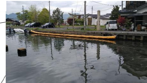
汚濁防止膜の撤去
