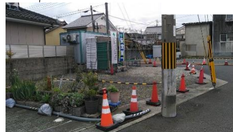
仮設事務所の撤去
