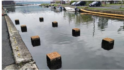
仮設杭の撤去
