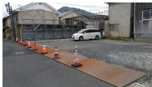
借地の復旧 (敷鉄板・防风シート)
