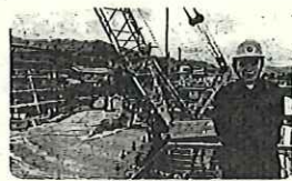
西舞鶴道路工事現場視察
