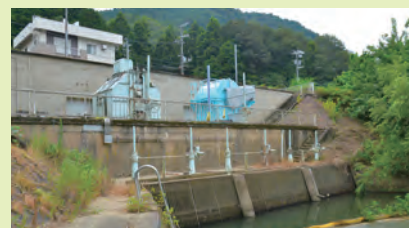
安定した水の供給を担う取水場（二箇取水場）
