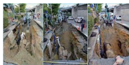
老朽水道管布設替え工事の様子
