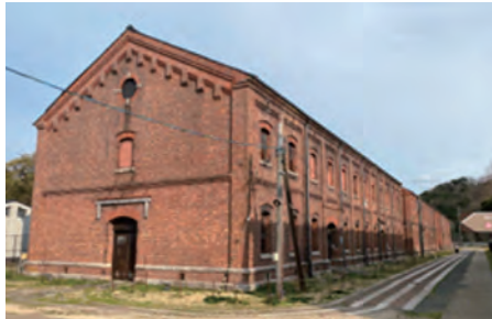
3棟で総額40億円超の赤れんがが保存修理
