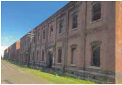
倉庫3棟の保存修理で40億円
