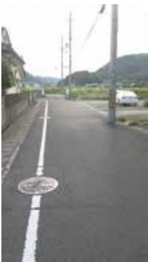
整備工事に着手される市道上良大將軍
