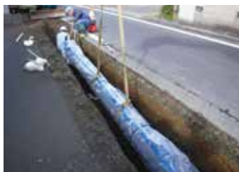
更新計画に基づき更新作業を進める水道管
