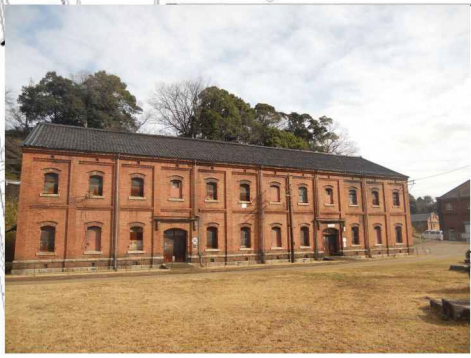
6号棟工事前外観
