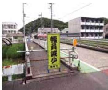
通行止めが続く浪速橋
